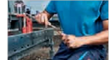
4. Reinigen Sie das Ende des Rohres mit rotierenden Bewegungen, um Kratzer parallel zum Rohr zu vermeiden
