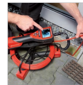
Inspektion von Regenabflussrohren
