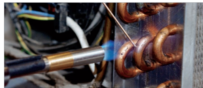
Hartlöten in der Kälte-Klima-Technik
