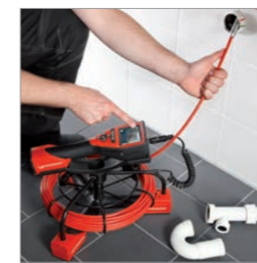
Inspektion vom Waschbeckenabfluss
