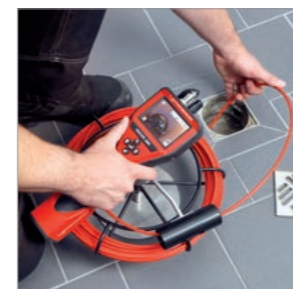
Inspektion von Bodenabläufen
