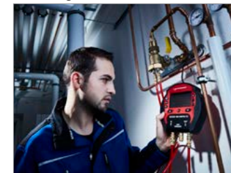
Belastungs- und Dichtheitsprüfung an Gasleitungen nach TRGI 2008
