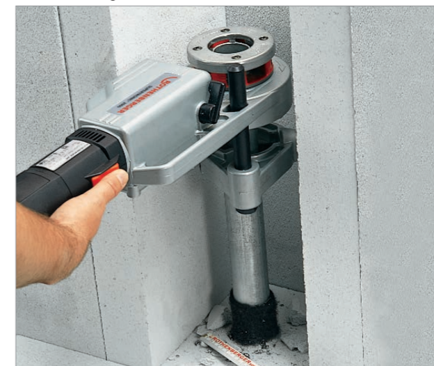
Arbeiten in beengten Stellen
