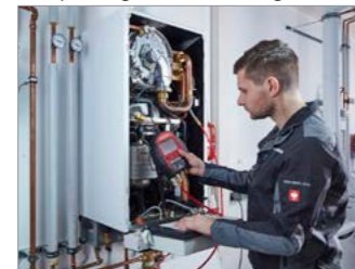
Überprüfung von Gasdruckreglern
