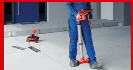
Mit Hilfe des Moduls ROLOC Plus HD kann der Ortungssender schnell und einfach gefunden werden.
